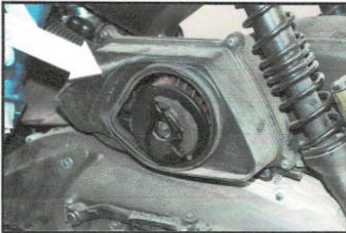
IMAGEN 12. Lado izquierdo tercio posterior se observa desprendimiento de la tapa del filtro de aire de la motocicleta de placas TZN-97E. (pag 62).
