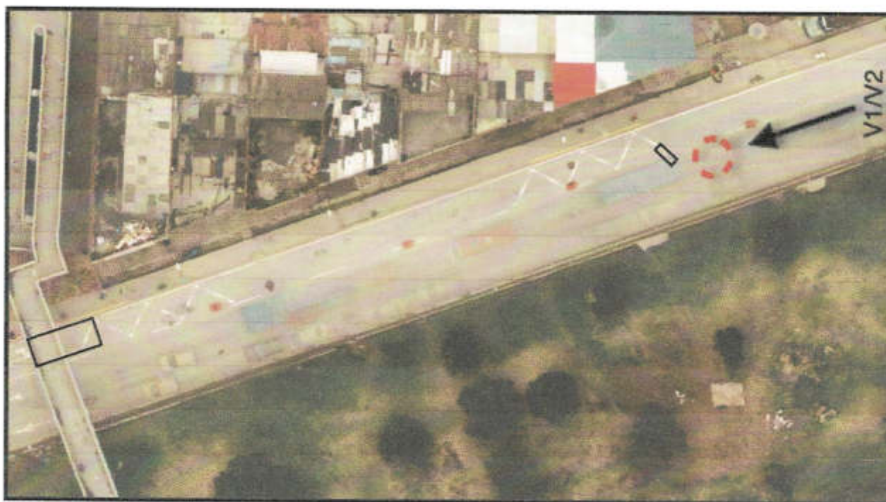
IMAGEN 3. Panorámica del lugar de los hechos, Av. Boyacá con calle 64A Sur sentido SUR - NORTE la flecha negra indica la trayectoria pre-impacto de la motocicleta, el círculo rojo indica la zona de impacto, se observa la vista superior del paso elevado peatonal donde se detuvo el vehículo numero 2 (volqueta).
