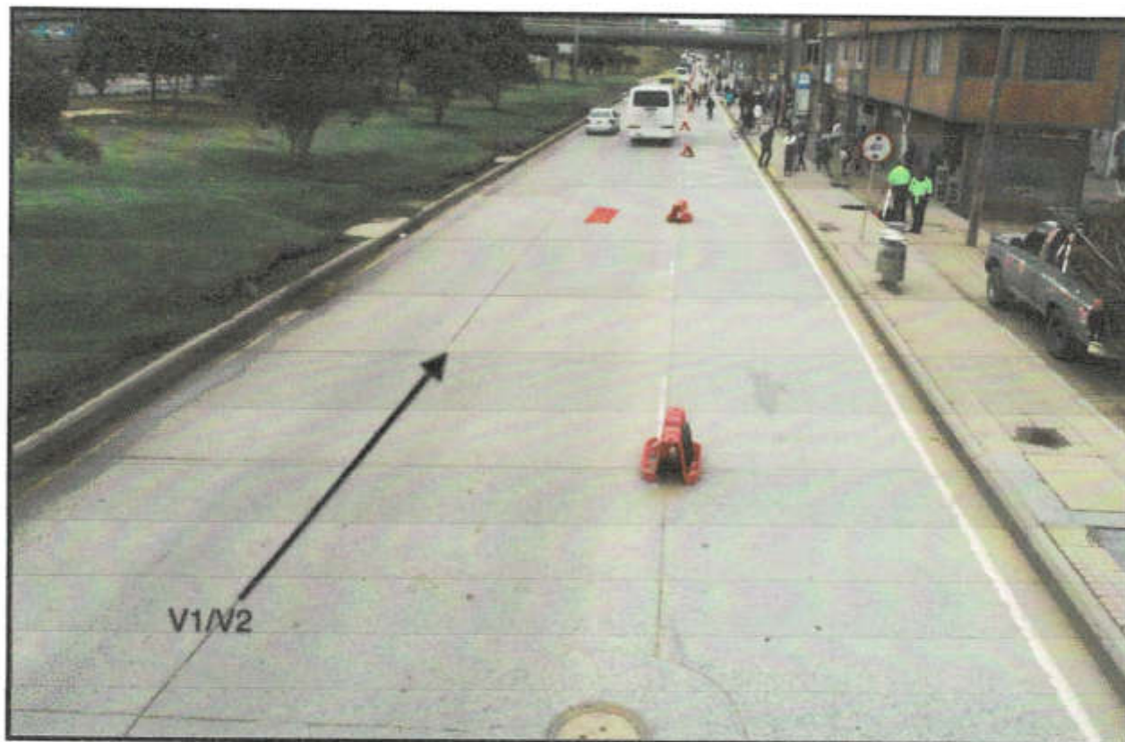
IMAGEN 5. Panorámica de la Av. Boyacá con calle 64A Sur, sentido SUR - NORTE; se señala la dirección de los rodantes previos al impacto , el punto rojo señala el área de la colisión que será demostrado en el numeral 4 del presente informe, se observa con más detalle que el demarcado vial para esta fecha ya es completamente imperceptible.
