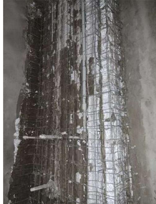
Igualmente tenemos dinteles en su mayoría por debajo del nivel entregado al residente, que ha tocado demoler, retirar malla, quemar icopor, instalar malla y ajustar. Esta actividad necesita personal para realizarlo ya que estaba comenzando a convertirse en retroceso de tajar el cielo raso con lamina.
