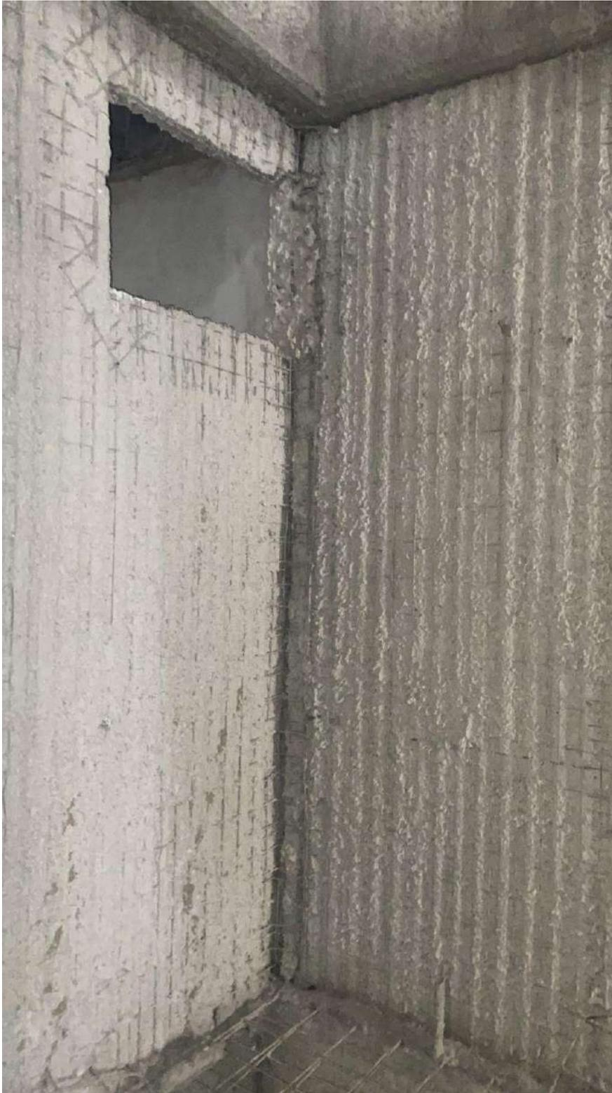
Mala instalación ventana vano interno de ventilación natural en baño principal
