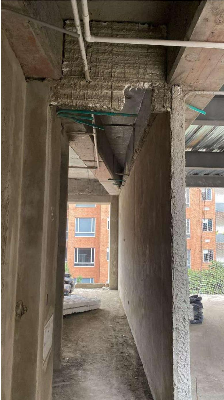
Muros safarreados sin rellenar correctamente, y sin pañetar
