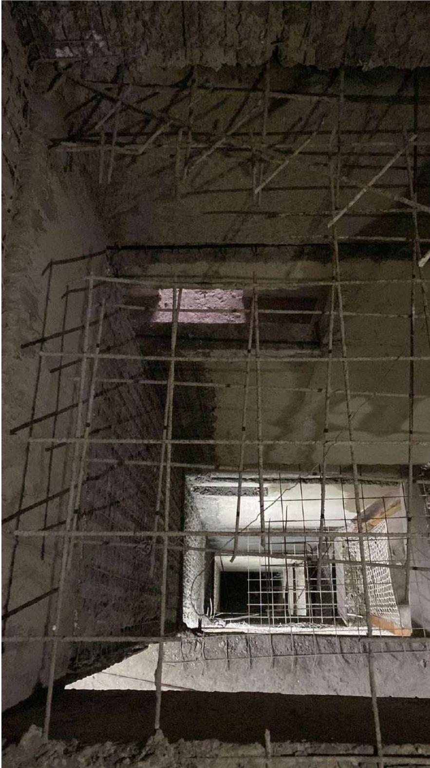
Mala instalación ventana vano interno de ventilación natural en baño principal, sin pañete ductos internos
