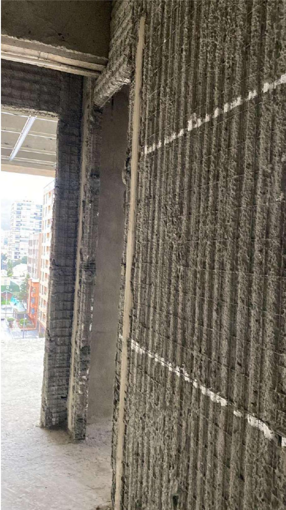
Muros sin pañetar y malla salida
