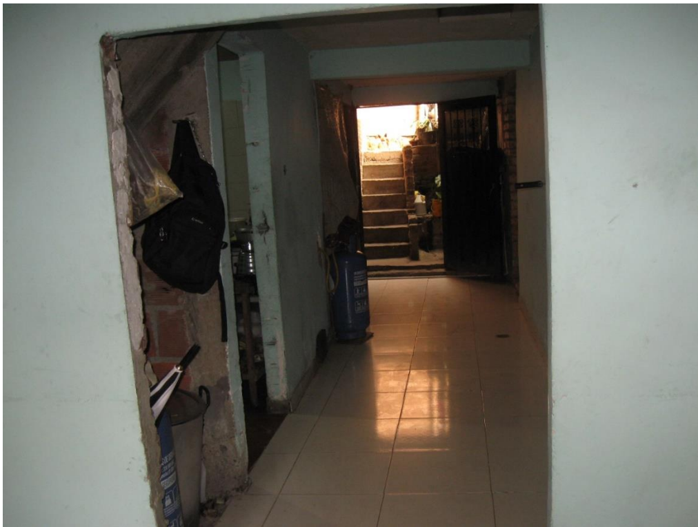
Fotografía No. 14.- Al fondo grada de acceso a segunda planta del inmueble
