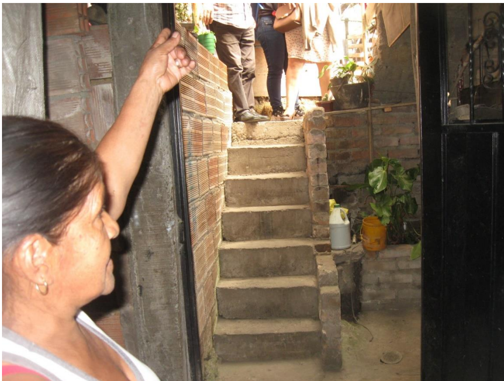
Fotografía No. 15.- Grada de acceso a segunda planta del inmueble Dirección: Calle 3 No. 0-56 Barrio La Pamba-Celular: 3216247961-3215826184-Popayán-Cauca Email: rubenbetancourt595 gmail.com-rudabeta42 gmail.com
