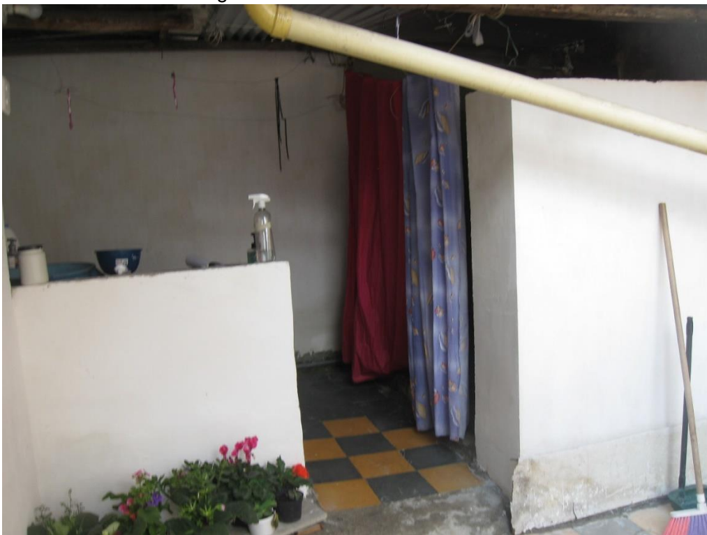
Fotografía No. 12.- Baño, sanitario y lavadero del inmueble
