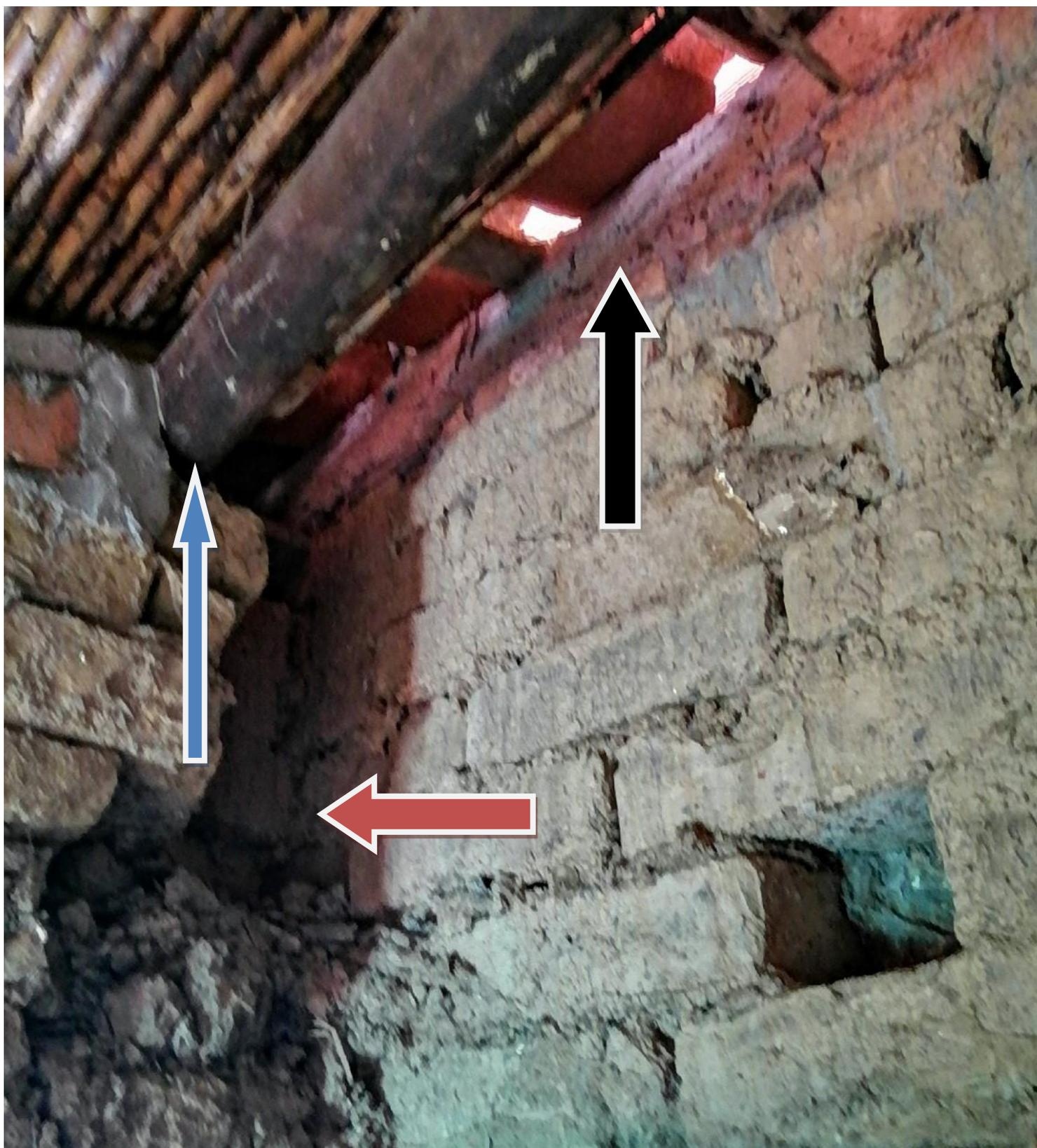
**28. ESTA ES LA MISMA COLUMNA PRINCIPAL Y LA VIGA EN MADERA DE LA CASA #10-33 DE LA FOTO ANTERIOR FOTO TOMADA POR EL LADO SUR DE LA COLUMNA:** y por destrozos en la parte superior está separada por este lado sur, de la pared lindero de la casa #10-33.
