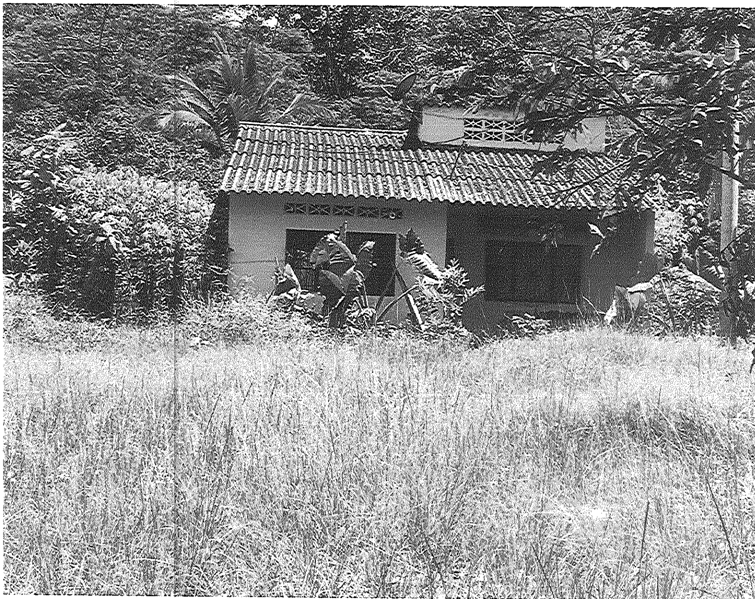
CASA UBICADA EN EL BARRIO VILLAZELANDIA MUNICIPIO DE SAN LUIS DE GACENO
