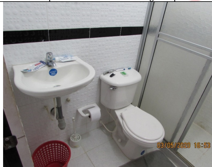
IMG41 Baño privado en habitación N°3 segundo piso
