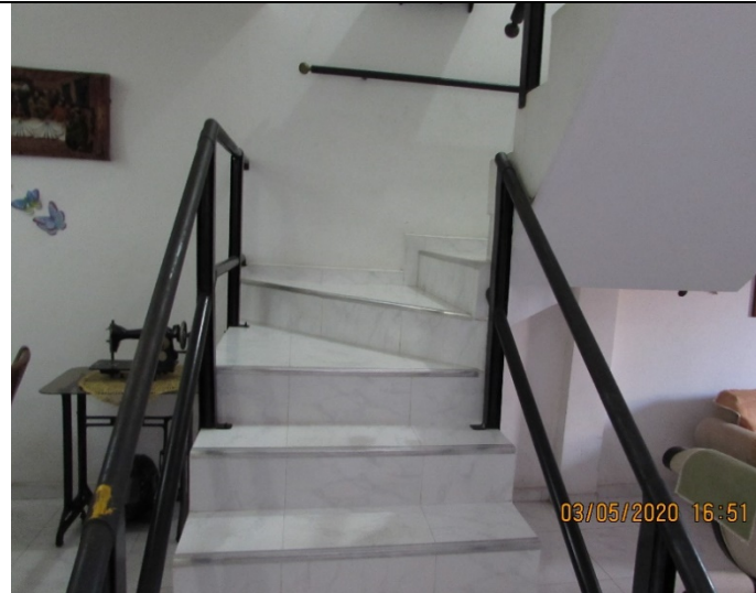
IMG15 Escalera de acceso al segundo piso
