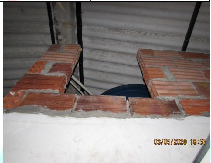
IMG66 Cubierta tercer piso teja asbesto cemento
