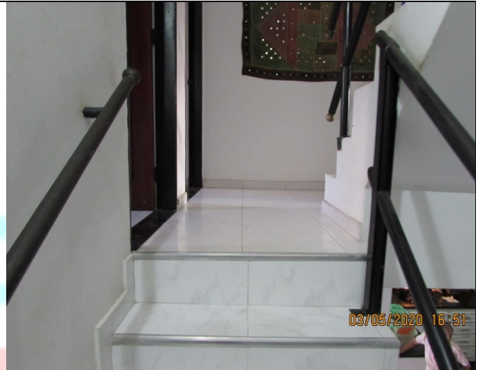
IMG16 Escalera de acceso al segundo piso
