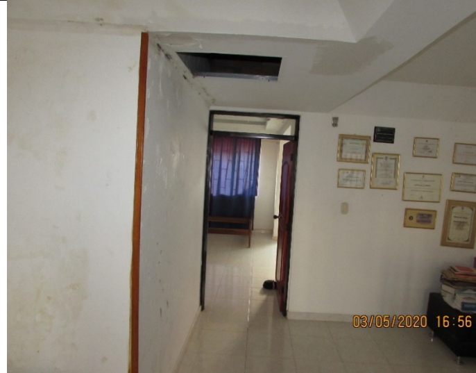
IMG55 Salón de estar tercer piso
