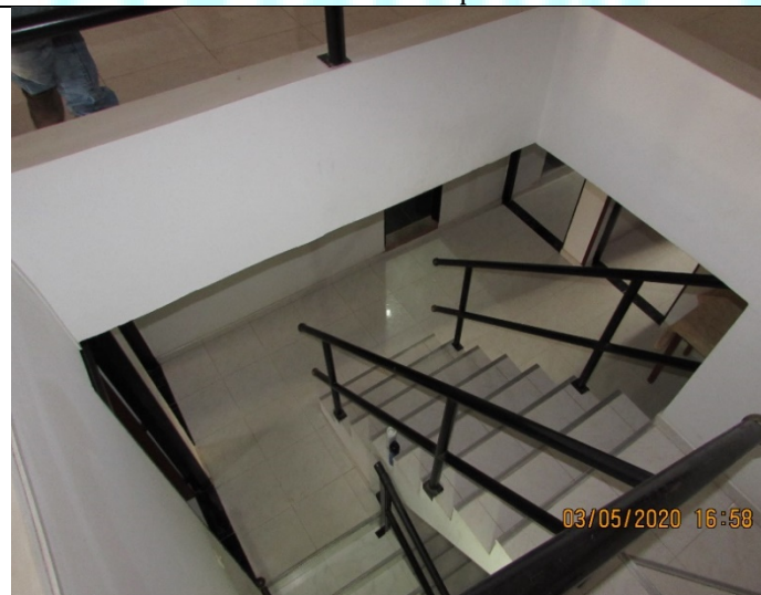
IMG49 Escalera de acceso al tercer piso
