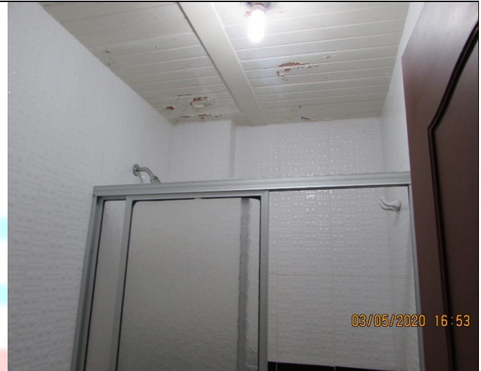
IMG40 Baño privado en habitación N°3 segundo piso
