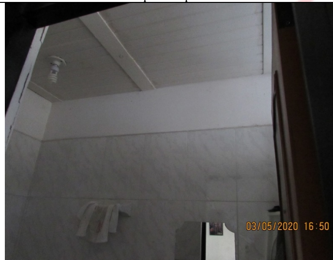
IMG11 Vista placa aligerada baño primer piso
