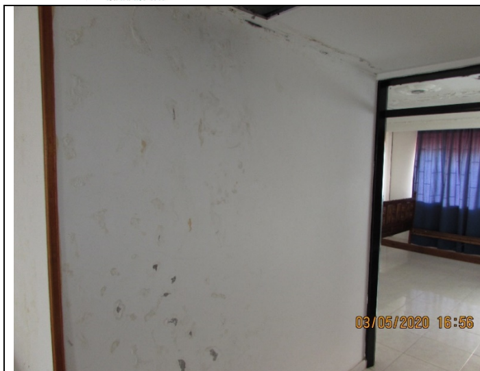
IMG57Salón de estar tercer piso
