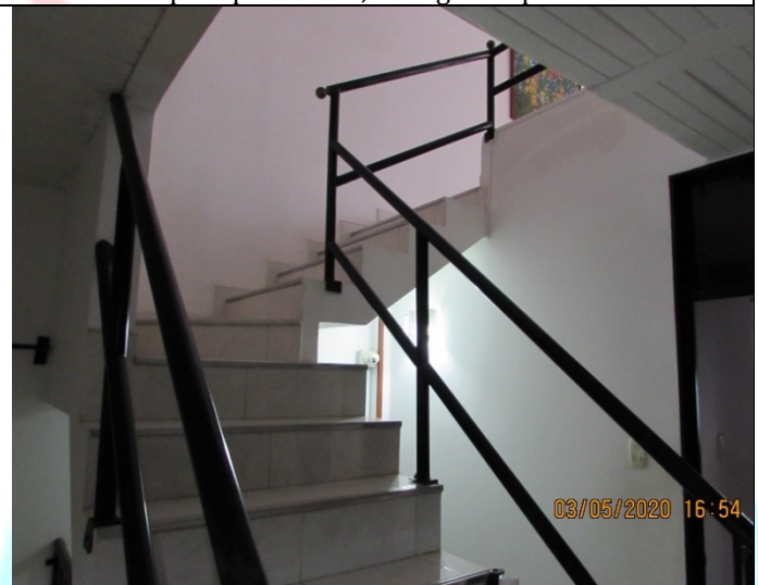
IMG48 Escalera de acceso al tercer piso
