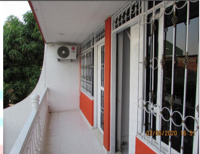
IMG22 Balcón habitaciones 1 y 2 segundo piso
