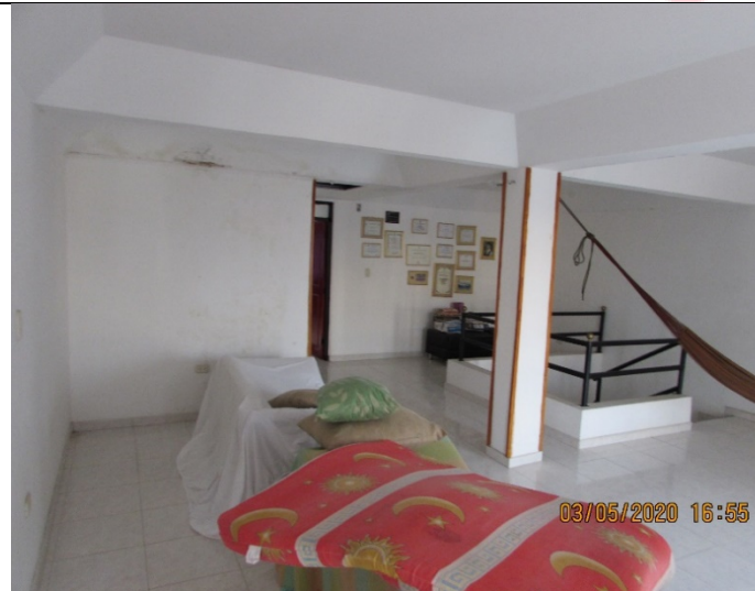
IMG53 Salón de estar tercer piso
