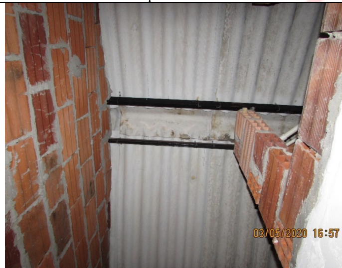
IMG65 Cubierta tercer piso teja asbesto cemento
