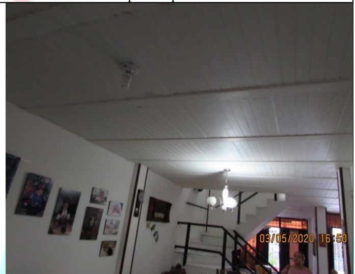
IMG12 Vista placa aligerada primer piso
