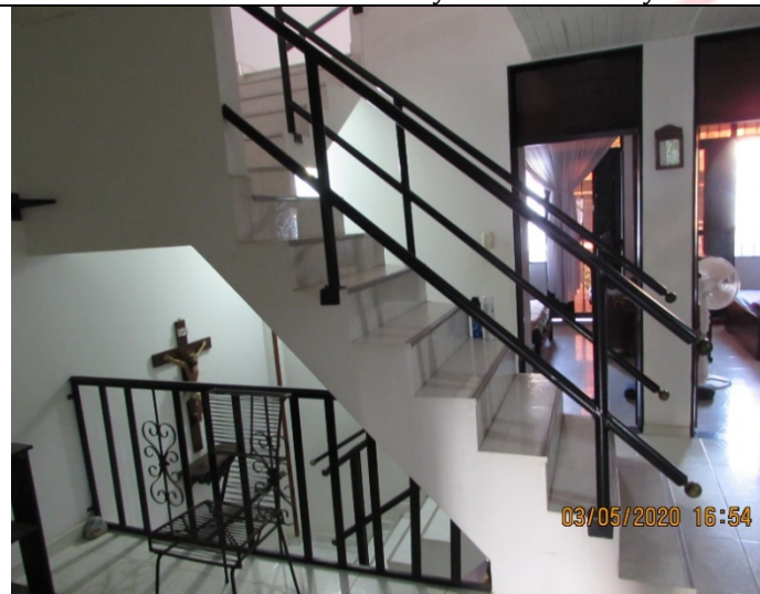
IMG47 Escalera de acceso al tercer piso
