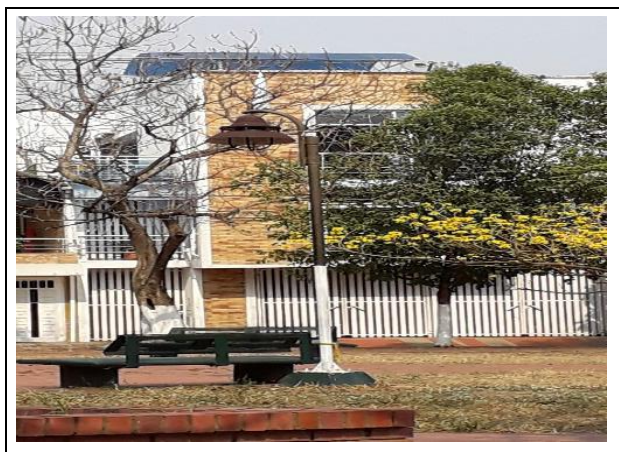
Fachada edificio (Apto 101)
