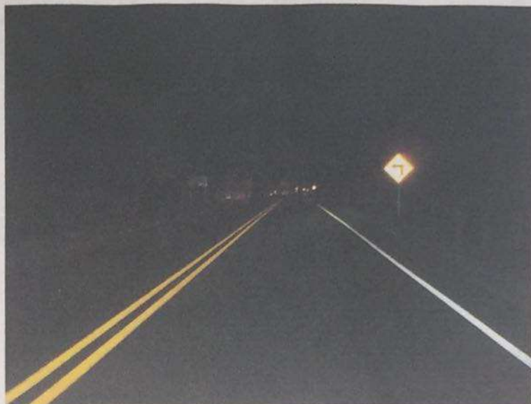
IMAGEN 01 FOTOGRAFIA PANORAMICA: REGISTRO OBTENIDO DESDE EL CARRIL DERECHO DE LA VIA LA PAILA – ARMENIA KM 15+100 SECTOR DE QUEBRADA NUEVA, DONDE SE OBSERVA EL DISEÑO DE LA VIA CON DOBLE LINEA CENTRAL CONTINUA COLOR AMARILLO, LINEA DE BORDE COLOR BLANCO EN AMBOS LADOS, MATERIAL ASFALTO EN BUEN ESTADO, SEÑAL DE TRANSITO SP-01 (CURVA PELIGROSA A LA IZQUIERDA), SIN COSAS SITUADAS DE MANERA ESTABLE, TIEMPO SECO.
