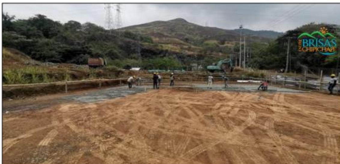
Labores en la Cimentación torre A, Fundición solado de limpieza, para armado refuerzos losa de cimentación.
