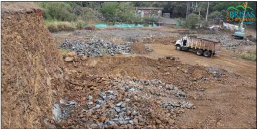
- Movimiento de tierra área edificio de parqueadero.
