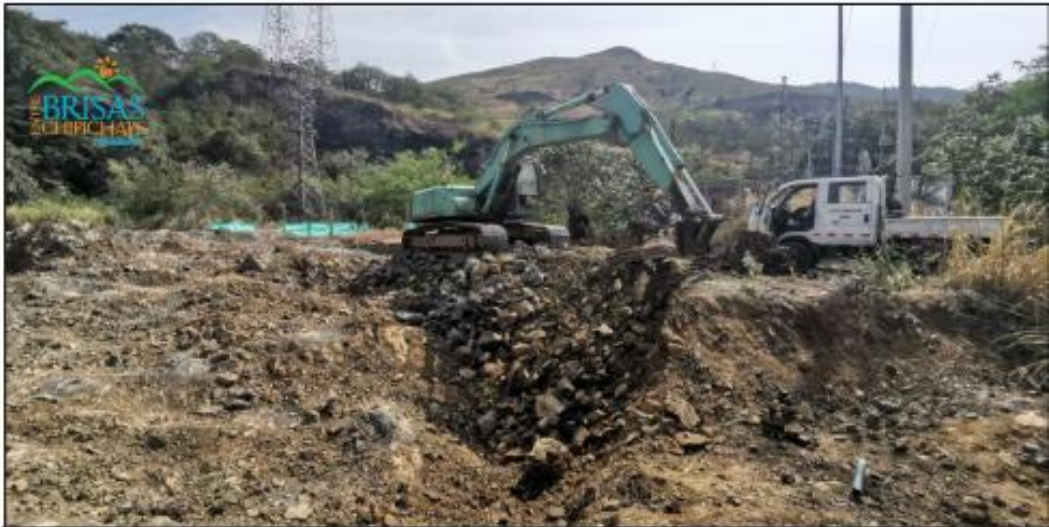
- Excavación sobre roca zona Edificio de parqueaderos.
