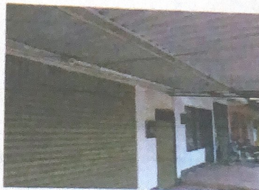
Fachada de la vivienda puerta de acceso a locales.
