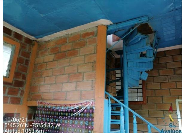
Se evidencia el mal estado de las escalas de acceso a la segunda planta.
