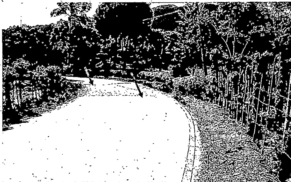
Fotografía 25. Otro hundimiento y rompimiento de la vía lindando con el predio de la Sra. Lina María Montoya, al fondo las construcciones realizadas sobre el depósito coluvial. A 250m de la mina de arcillolita Rolando de Sumicol.
