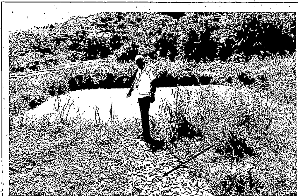
Fotografía 8. Detalle al estanque de sedimentación, observe el vertedero de aguas construido con manto de geotextil y el filtro de gravas.
