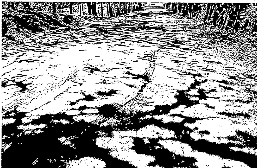
Fotografía 20. Continúan los hundimientos verticales hasta de 15cm. de profundidad. Ubicados a 5,5 km de la mina de arcillolita Rolando de Sumicol Sumicol.
