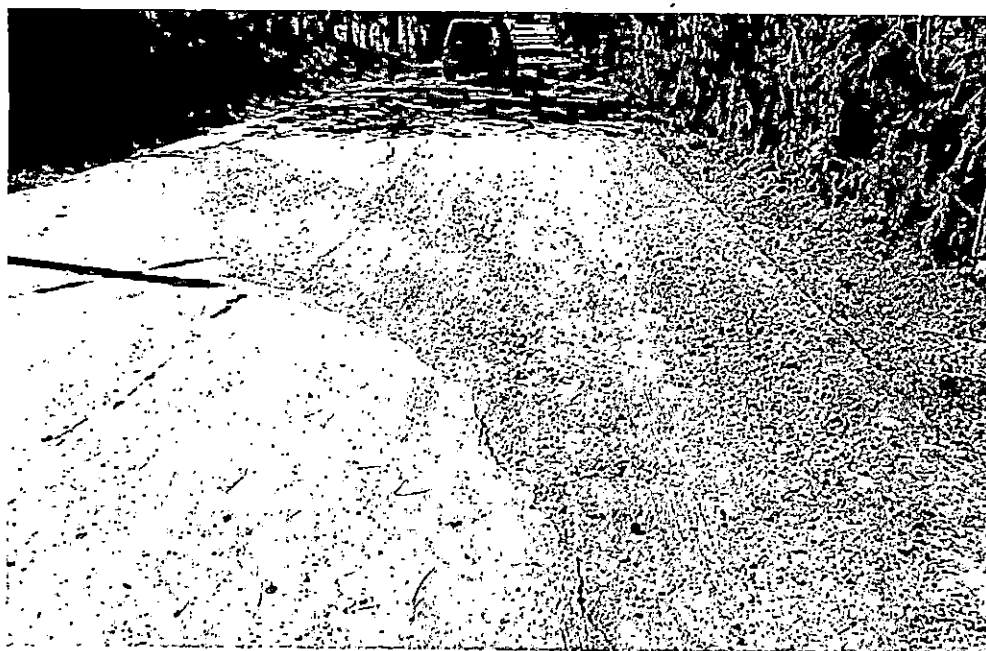
Fotografía 19: Hundimiento y rompimiento de la carpeta asfáltica por hundimiento del material infrayacente. Ubicado a 7,5 km de la mina de arcillolita Rolando de Sumicol.
