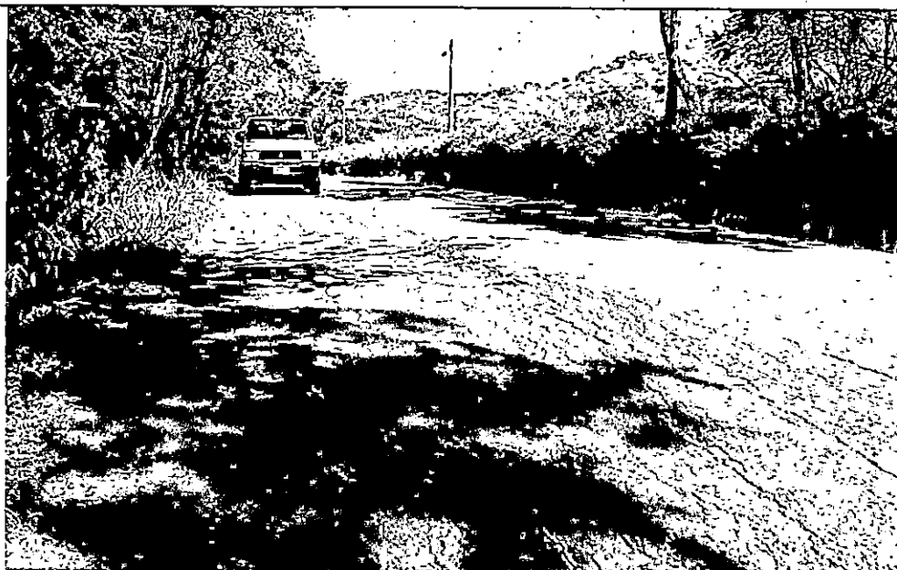
Fotografía 16. Grietas y hundimiento de la vía por la expandibilidad natural del suelo. Ubicadas a 12,3 km de la mina de arcillolita Rolando de Sumicol
