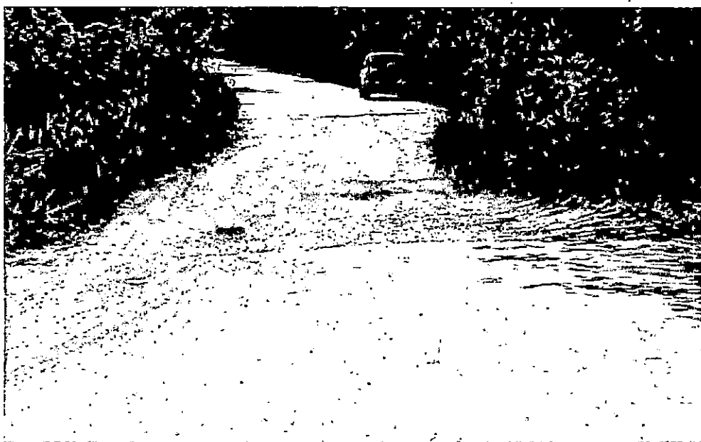
Fotografía 21. Hundimiento con desplazamiento y rompimiento de la carretera. Ubicada a 4,1 km de la mina de arcillolita Rolando de Sumicol.
