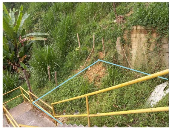
**ANDÉN SERVIDUMBRE:** Se trata de un paso peatonal encima de un barranco o desnivel positivo, que sería el frente de la construcción, con piso en cemento y barandales de hierro, ocupa unos 5.47 m<sup>2</sup> del lote objeto del embargo. Como está a sobre nivel, se observa un muro de contención sin estructura, solo de adobes que es lo que sostiene el barranco
