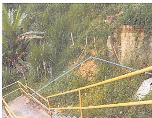
**ANDÉN SERVIDUMBRE:** Se trata de un paso peatonal encima de un barranco o desnivel positivo, que sería el frente de la construcción, con piso en cemento y barandales de hierro, ocupa unos 5.47 m<sup>2</sup> del lote objeto del embargo. Como está a sobre nivel, se observa un muro de contención sin estructura, solo de adobes que es lo que sostiene el barranco
