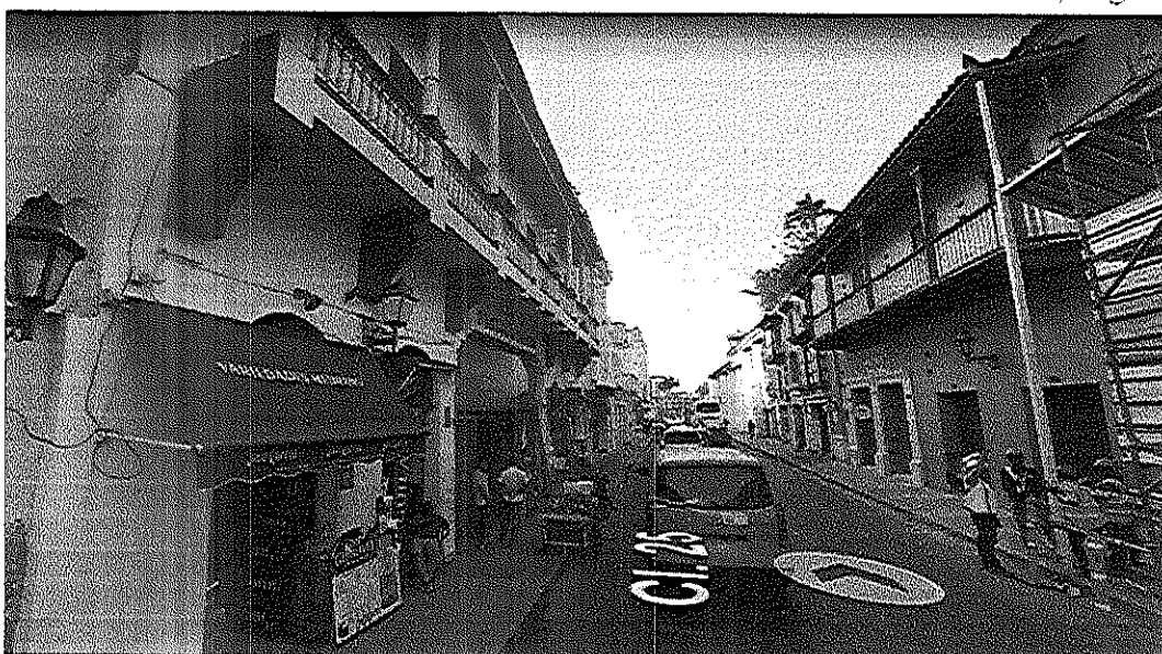
Fachada de la edificación sobre la Calle Larga (calle 25)
