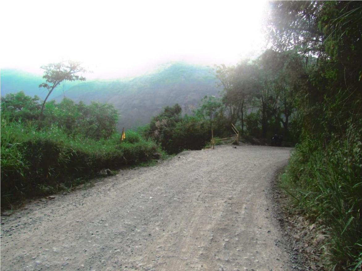
**FOTOGRAFIA No.3:** fotografía tomada en sentido Salamina – Pacora vereda Rungano, donde se observan las características de la vía, estado, ausencia de demarcación, señalización y elementos de seguridad.
