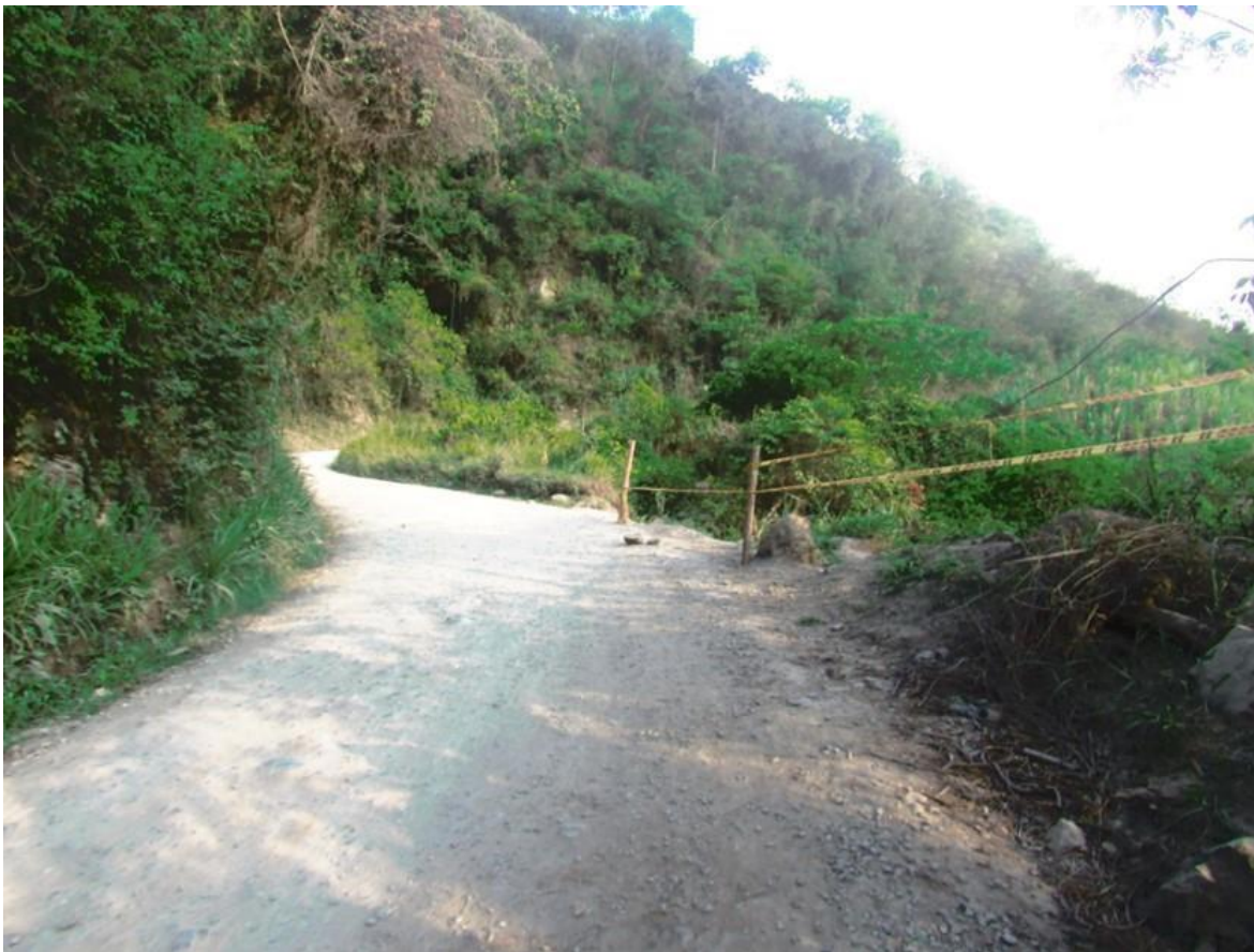
FOTOGRAFIA No.2: Fotografía tomada en sentido Pacora – Salamina vereda Rungano, a la altura de la curva donde ocurren el siniestro, se observan las características generales de la vía, estado, ausencia demarcación y señalización. En este sentido se desplazaba el vehículo afiliado a EMPRESA ARAUCA S.A.
