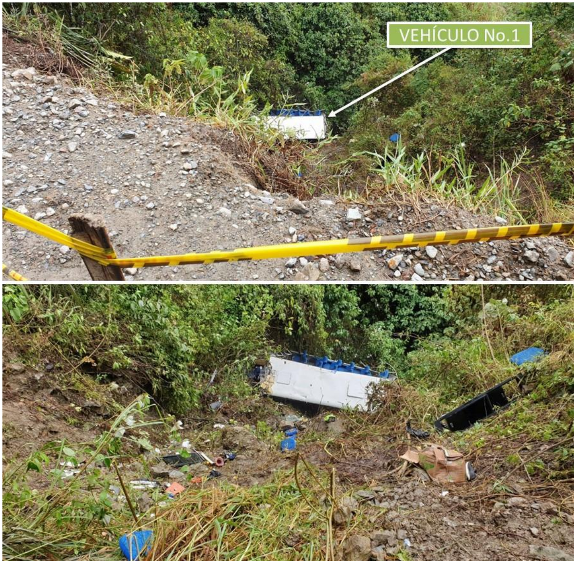
IMAGEN No. 04: Imagen compuesta por registros fotográficos del día de los hechos donde se observa la posición final del bus aproximadamente 60m abajo del borde de vía, sobre la ladera contigua a la calzada; se identifican irregularidades del borde de vía, rastros y vestigios dejados en el trayectoria en descenso y el estado final de la carrocería.
