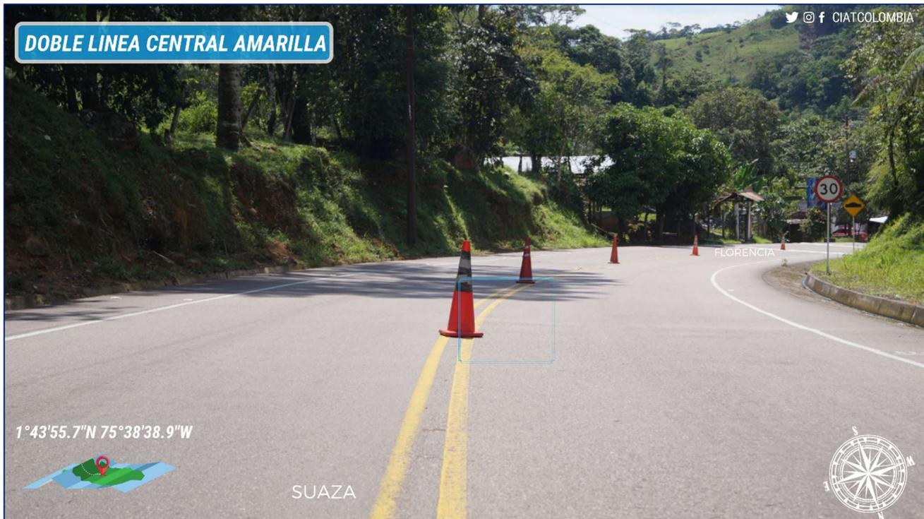
**IMAGEN 7.** En la imagen se observa sobre la corana de la vía, las líneas dobles centrales amarillas.
