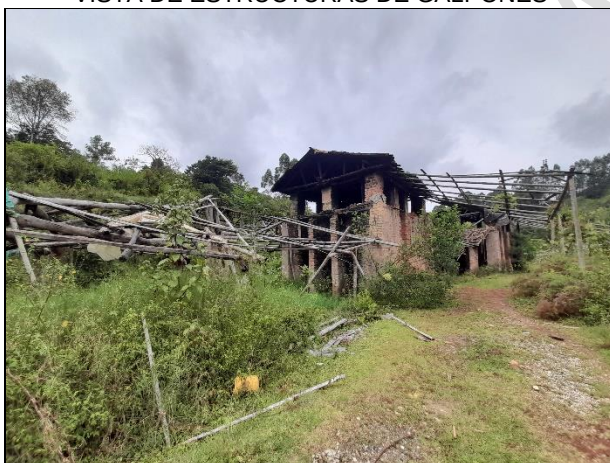
VISTA INTERNA LOTE
