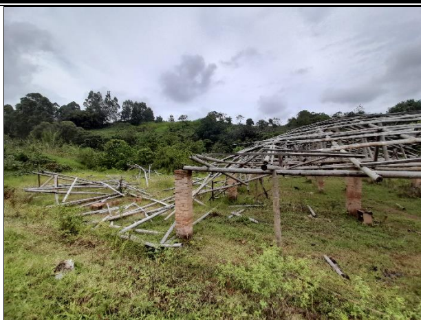
VISTA DE ESTRUCTURAS DE GALPONES
