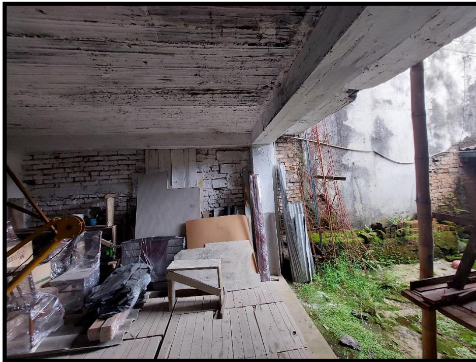
Reforzamiento de bodega
