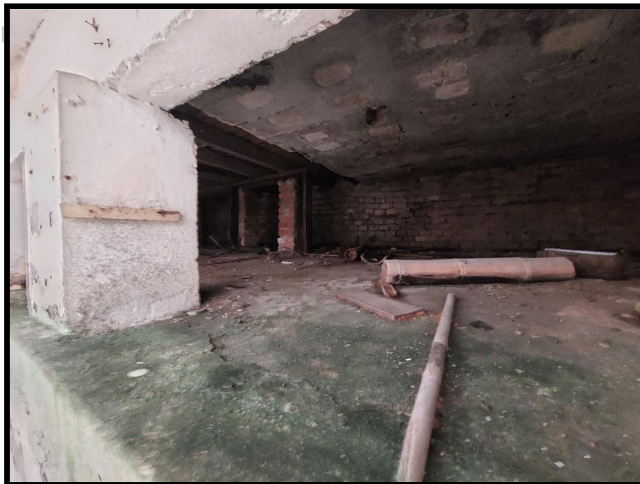
Vista de la cimentación
