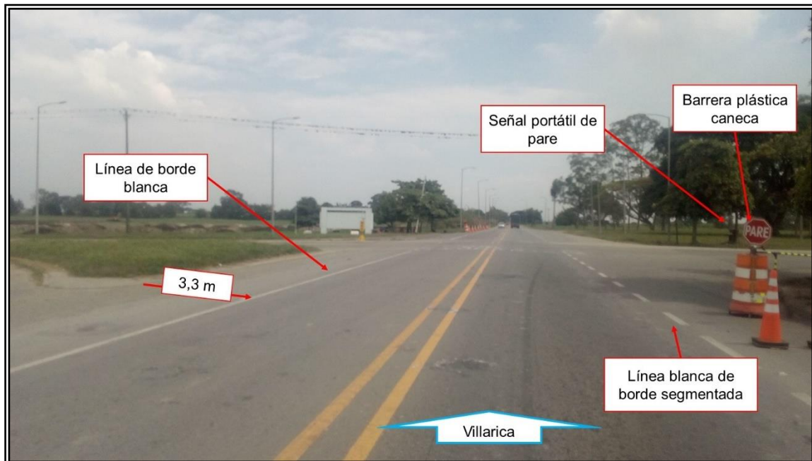
Imagen 2.6 Condiciones de la vía
