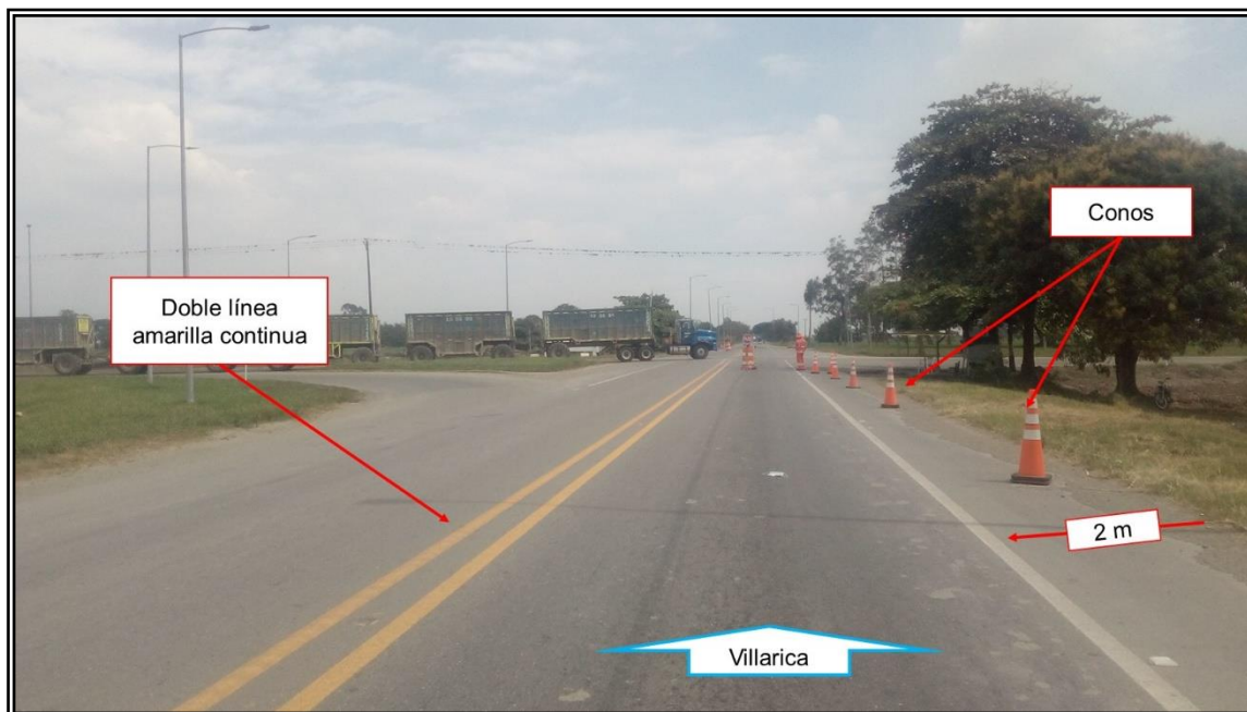
Imagen 2.4 Condiciones de la vía
