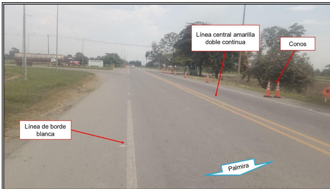
Imagen 2.2 Condiciones de la vía
