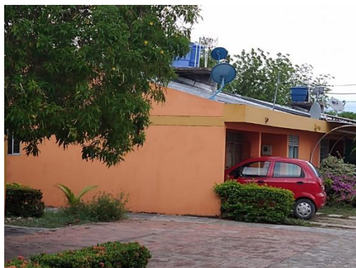
FACHADA DEL INMUEBLE (avalúo)
