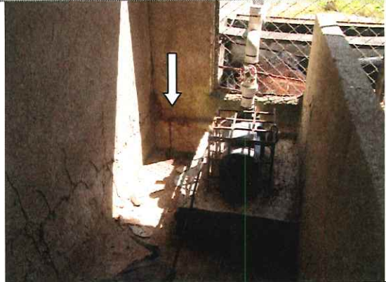
IMAGEN 6. Toma 105-7634, Primer Plano, se observa la Turbina Electrica, y a la izquierda manchas rojas al parecer sangre de la victima SANTIAGO RAFAEL MARQUES PALACIO,
