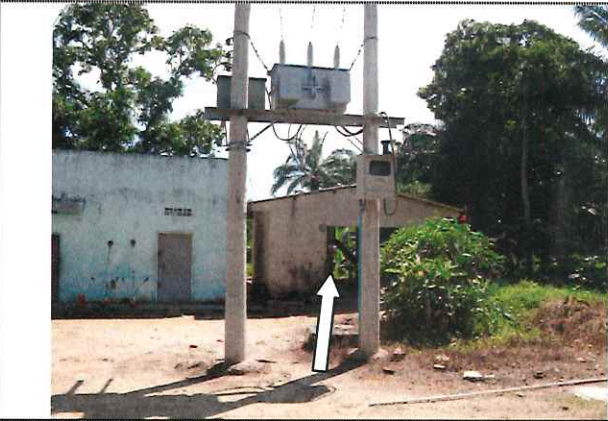
IMAGEN 3. Toma 105-7631, Plano General, se observa las características generales del cuarto de maquina (Motor Electrico) y en la parte exterior de observa dos postes eléctricos con un tranformador reductor de voltaje para llevarlo a 330 V. (Voltios).
