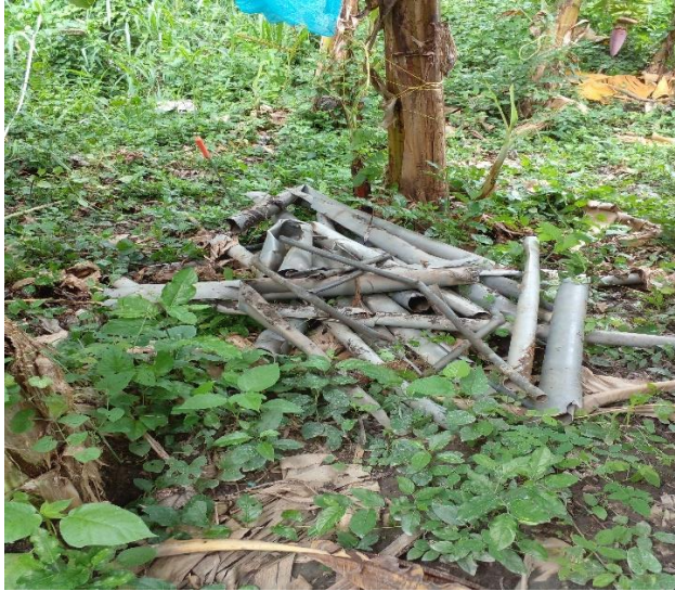
TUBERÍA DE RIEGO SACADA DE LA TIERRA POR EL BULLDOZER
