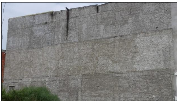
F.5 costado oriental de predio.
