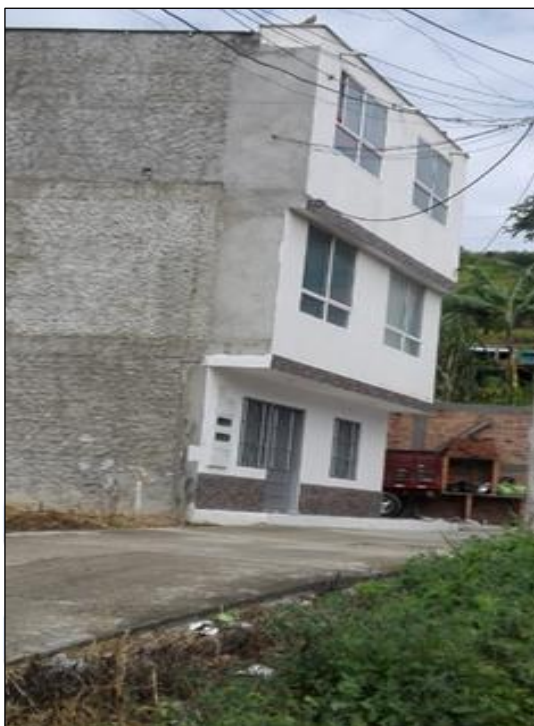
* Fachada principal del predio.
