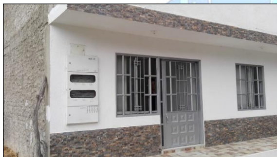
F.11 primer piso, frente a la vía.
