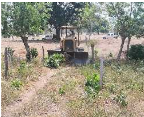
Foto No.9 Trabajo de bulldozer. (ANTES)
