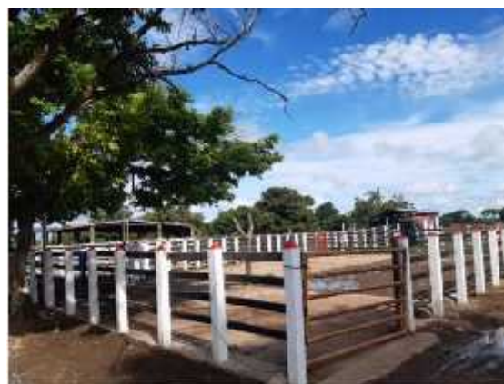
Foto No.6 Mejoras y reconstrucción de corrales. (DESPUES)
