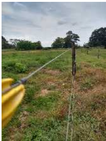
Foto No.13 Construcción de cercas eléctricas.
