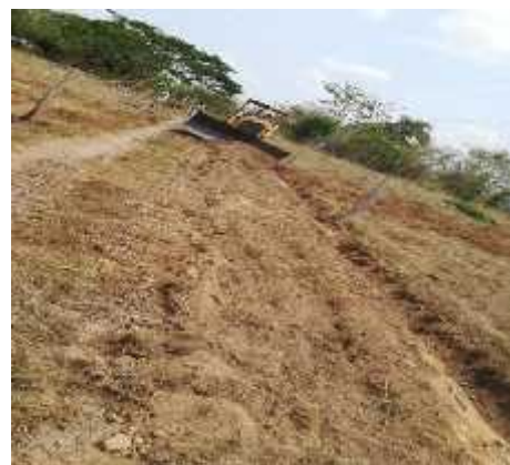
Foto No.10 Trabajo de bulldozer (ANTES)
