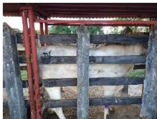
Foto No.4 Mejoras y reconstrucción de corrales (DESPUES)
