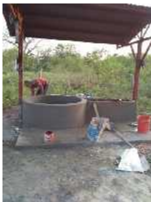
Foto No.3 Construcción de bebederos.
