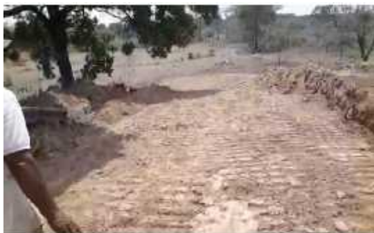
Foto No.11 Trabajo de bulldozer (DESPUES)
