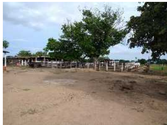
Foto No.2 Mejoras y reconstrucción de corrales (DESPUES)
