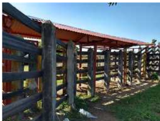
Foto No.3 Mejoras y reconstrucción de corrales. (DESPUES)
