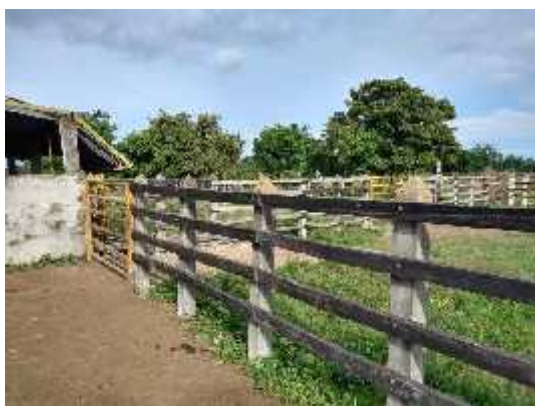
Foto No.5 Mejoras y reconstrucción de corrales.
