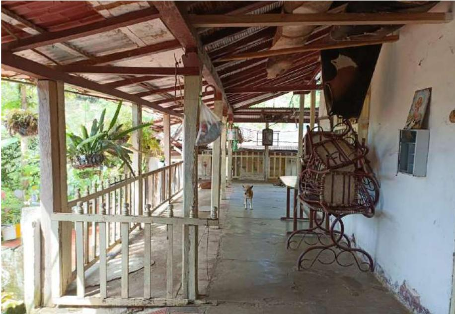
**AMPLIACION DE PISO EN CONCRETO Y CUBIERTA EN MADERA Y ETERNIT X DON JOSE**
