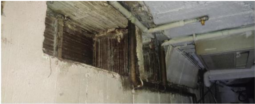
PARED QUE LIMITA CON LA CALLE - INTERIOR LOSA
