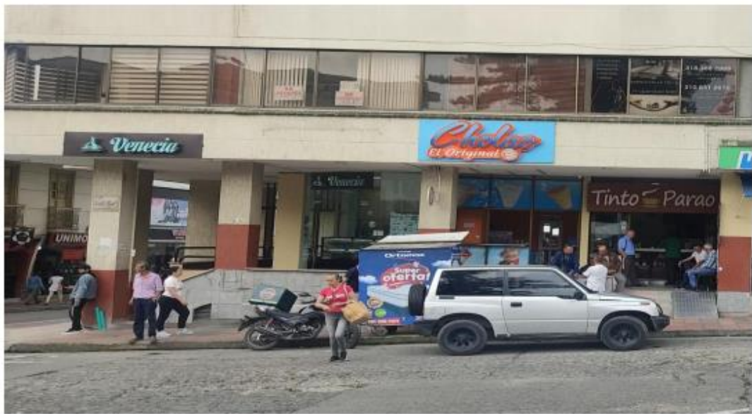
FACHADA PRINCIPAL - ACCESO PRINCIPAL
