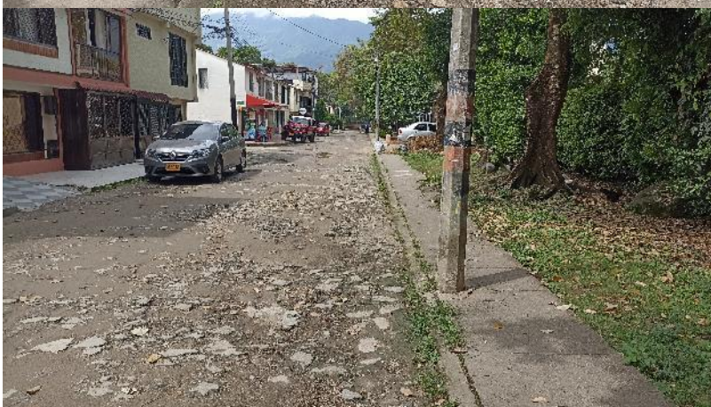
VIA DE ACCESO CALLE 79
