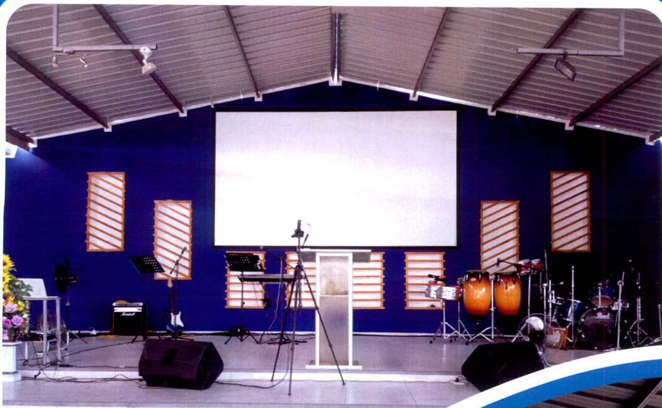
Vista Global del Altar y parcial de la cubierta y la estructura metálica
