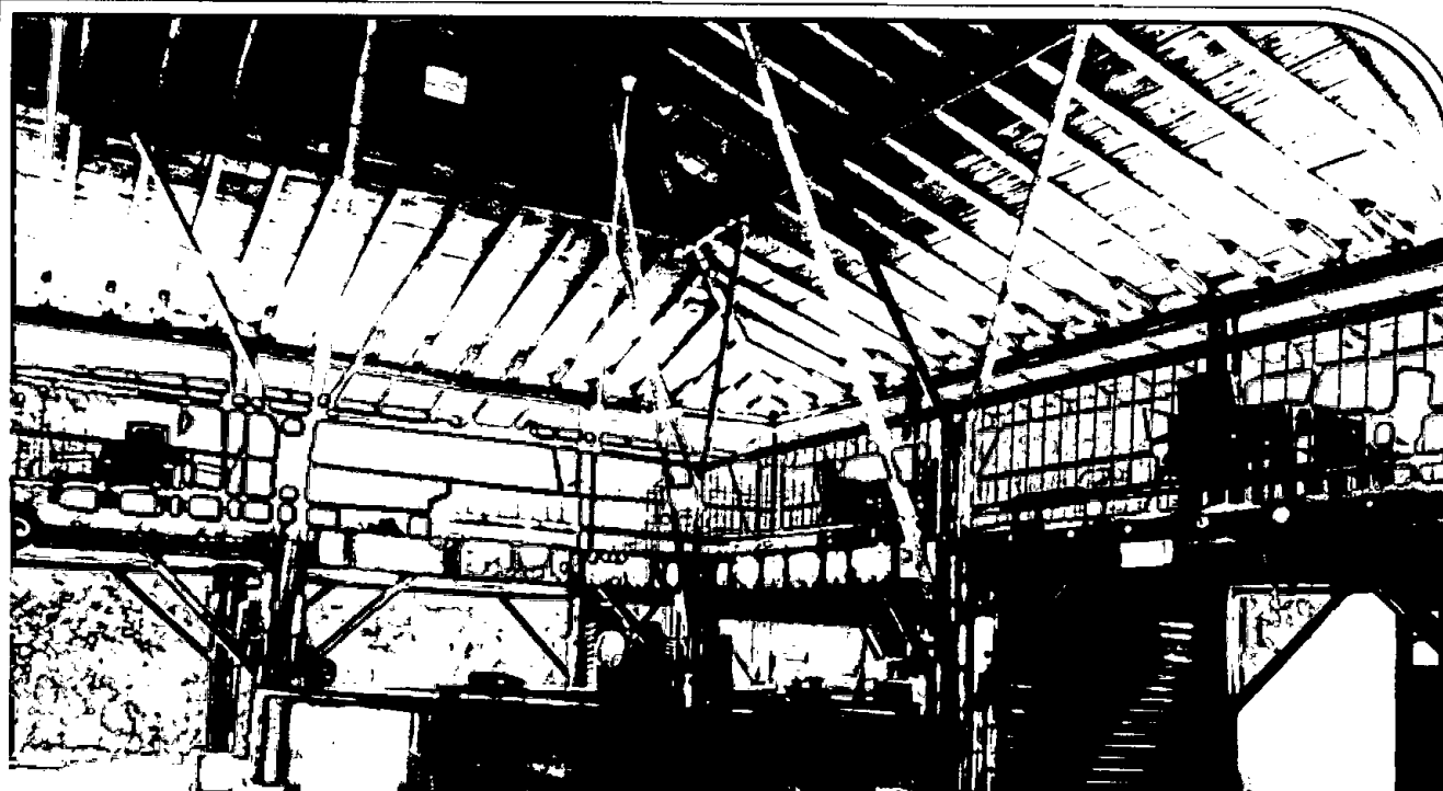
Vista y estado actual de la pasarela y la estructura del Kiosco
