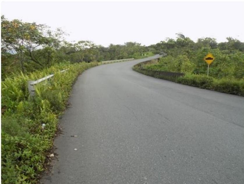
**FOTOGRAFIA No.1:** fotografía (Enero 2020) tomada en sentido Bajo Calima – Villa Estela en aproximación a la curva del Km 2+200, donde se observan las características generales del tramo de vía, morfología, estado, sin demarcación, con señalización vertical. En este sentido se desplazaba el vehículo No.2 Motocicleta. y No.2 Tractocamión
