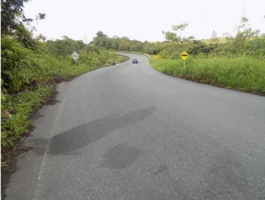
**FOTOGRAFIA No.2:** fotografía tomada en sentido Villa Estela – Bajo Calima en aproximación a la curva del Km 2+200, donde se observan las características generales del tramo de vía, morfología, estado, señalización, sin demarcación.
