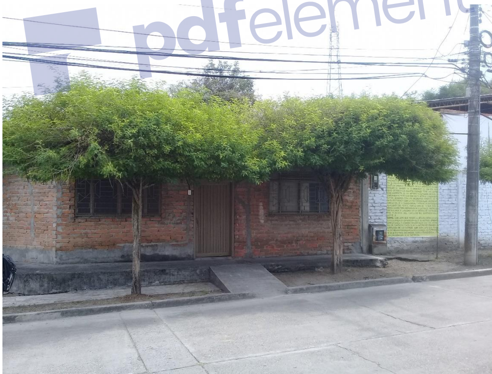
FACHADA PRINCIPAL LOTE 1 HERCILIA MONTOYA CORREA Transv. 7ª # 20-05
