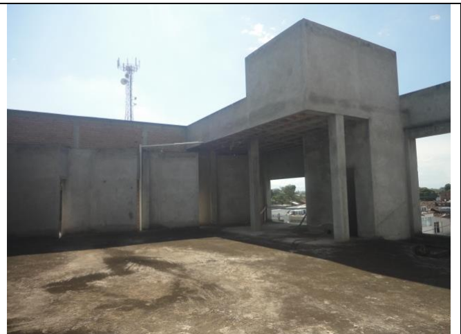
Nivel 4 sin cubierta
