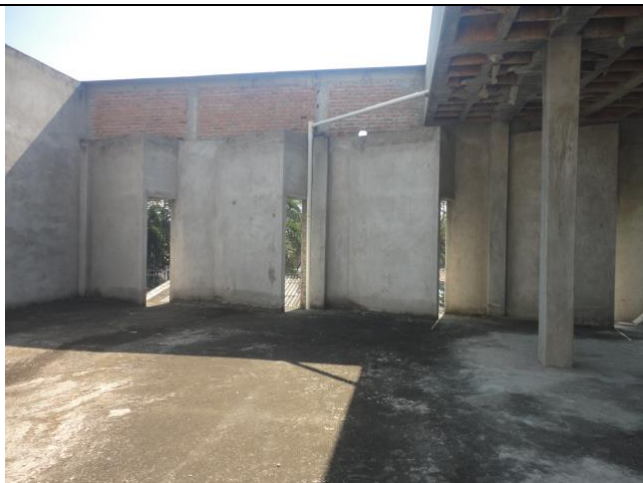
Nivel 4 sin cubierta
