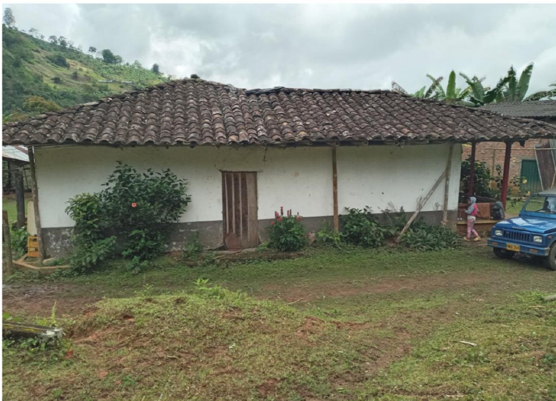
Foto 2. Vivienda principal fachada lateral de predio objeto de avaluo comercial.
