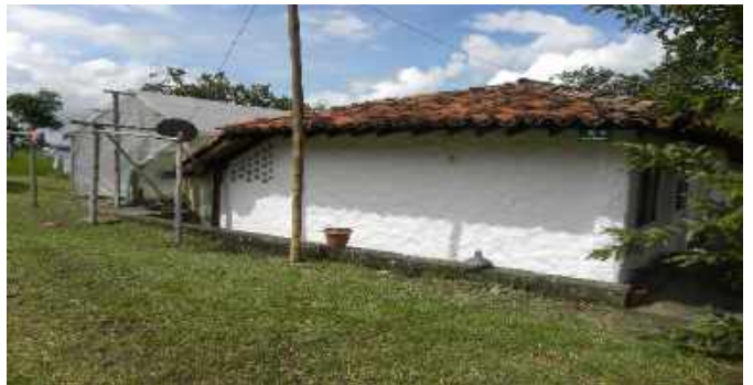
Fachada del Inmueble
