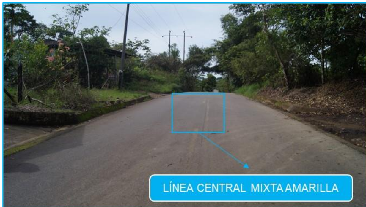
IMAGEN 7. En la imagen se referencia línea central mixta amarilla la cual habilita sentido Albania – Curillo el adelantamiento permitido con la línea segmentado en su costado.
