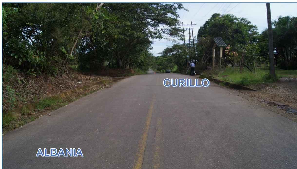
IMAGEN 6. En la imagen se aprecia el sentido de circulación de la vía.
