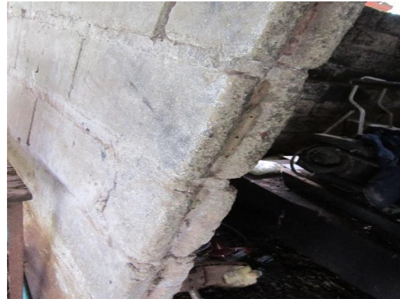
Cuarto de máquinas.
