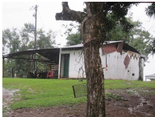
Bodega y cuarto máquinas.
