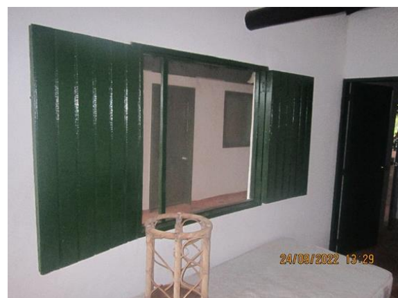
Ventana interior cuarto. Casa principal.
