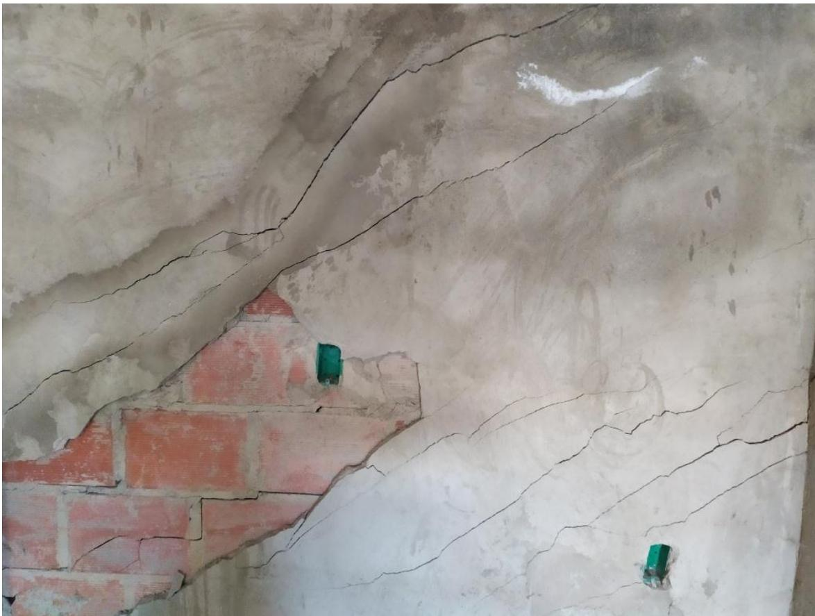
Fotografía 7, Alcobas, Patología Estructural, Fisuras.
