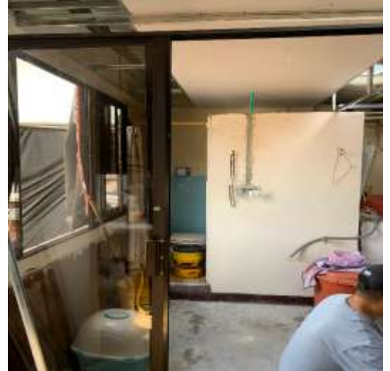
NIVEL 3 EN REPARACION
