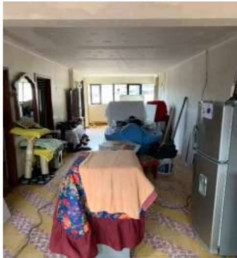
NIVEL 3 EN REPARACION
