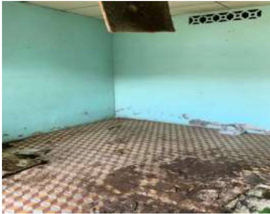
PISOS DETERIORADOS
