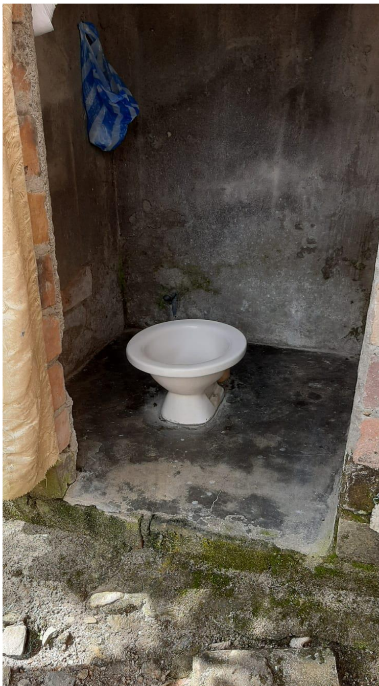
Casa de habitación vereda el Porvenir en Mercaderes Cauca. - 24 de mayo de 2022 – SANITARIO (Pero no hay acueducto)
