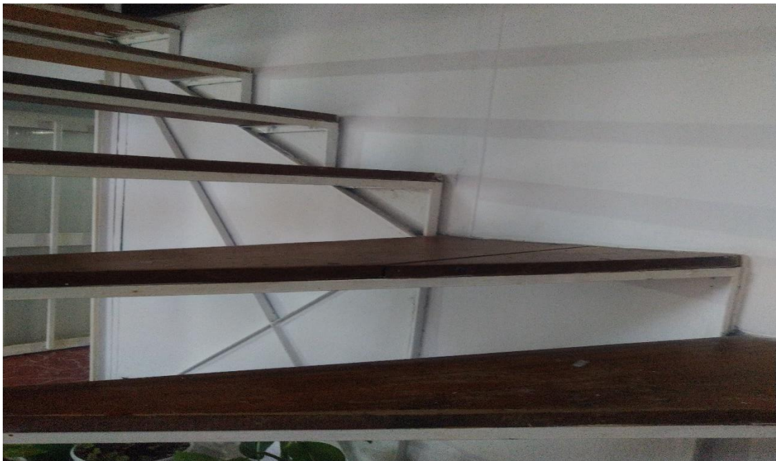
Escaleras de la casa.
