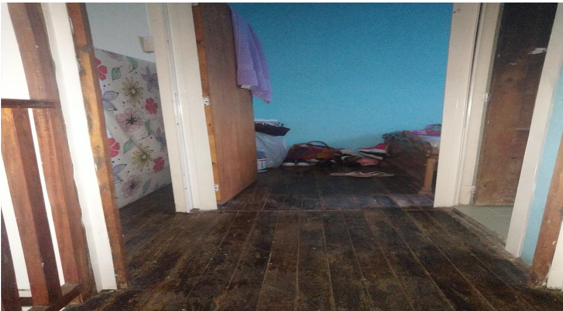
Pasillo de las alcobas y el baño.
