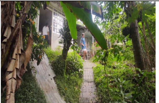
Fachada de la vivienda
