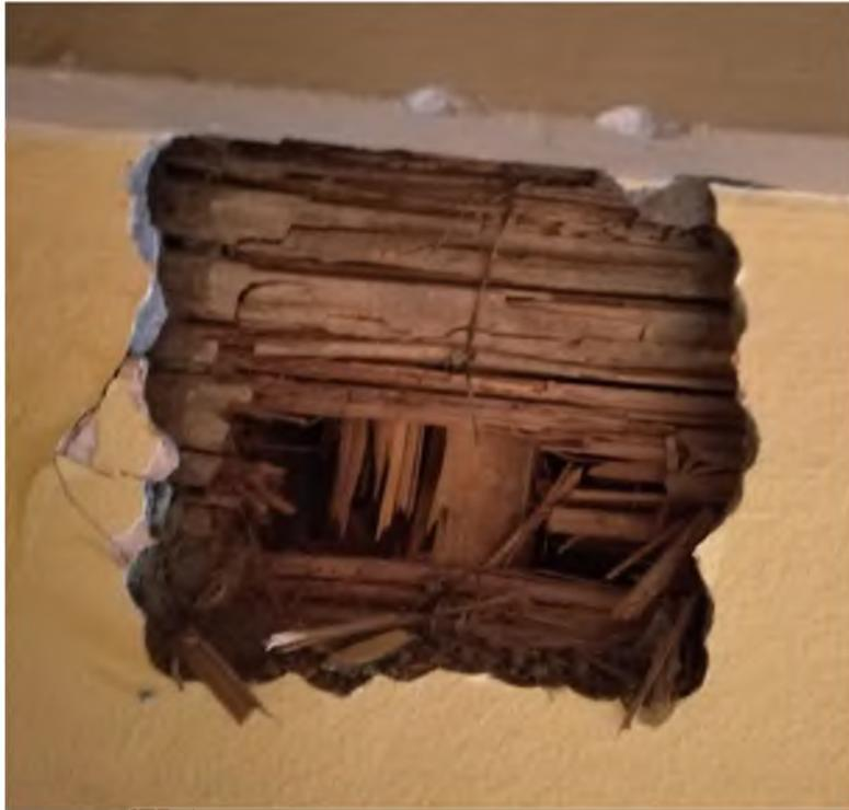
Fotografía que muestra estado de la columna que soporta la viga.
