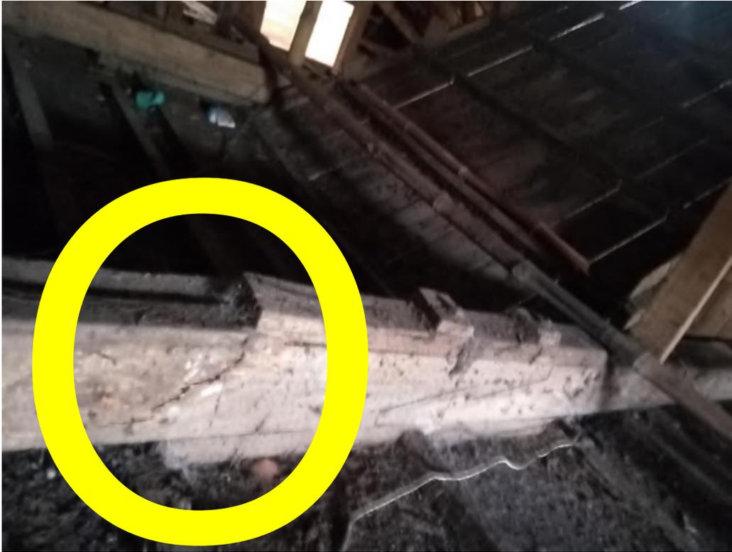
Fotografía de la viga que se encuentra fracturada.
