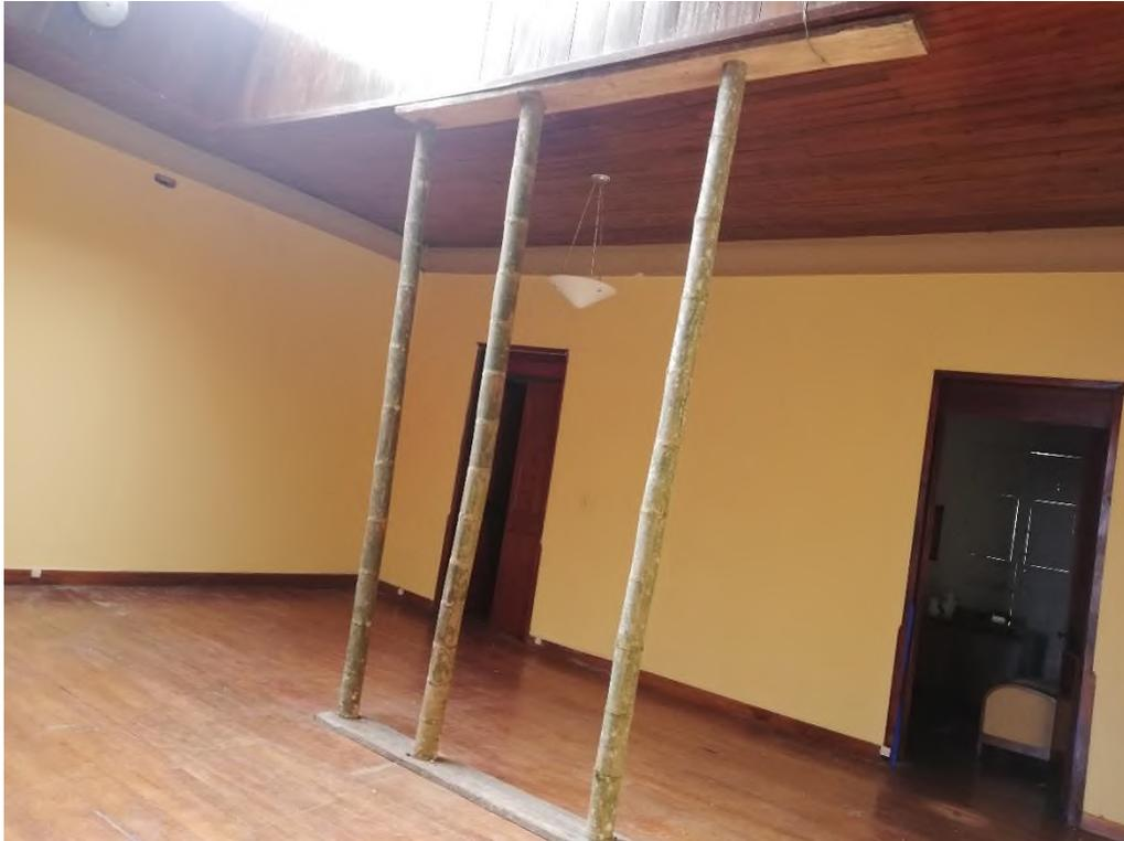
Fotografía de la sala. Viga alzaprimada.
