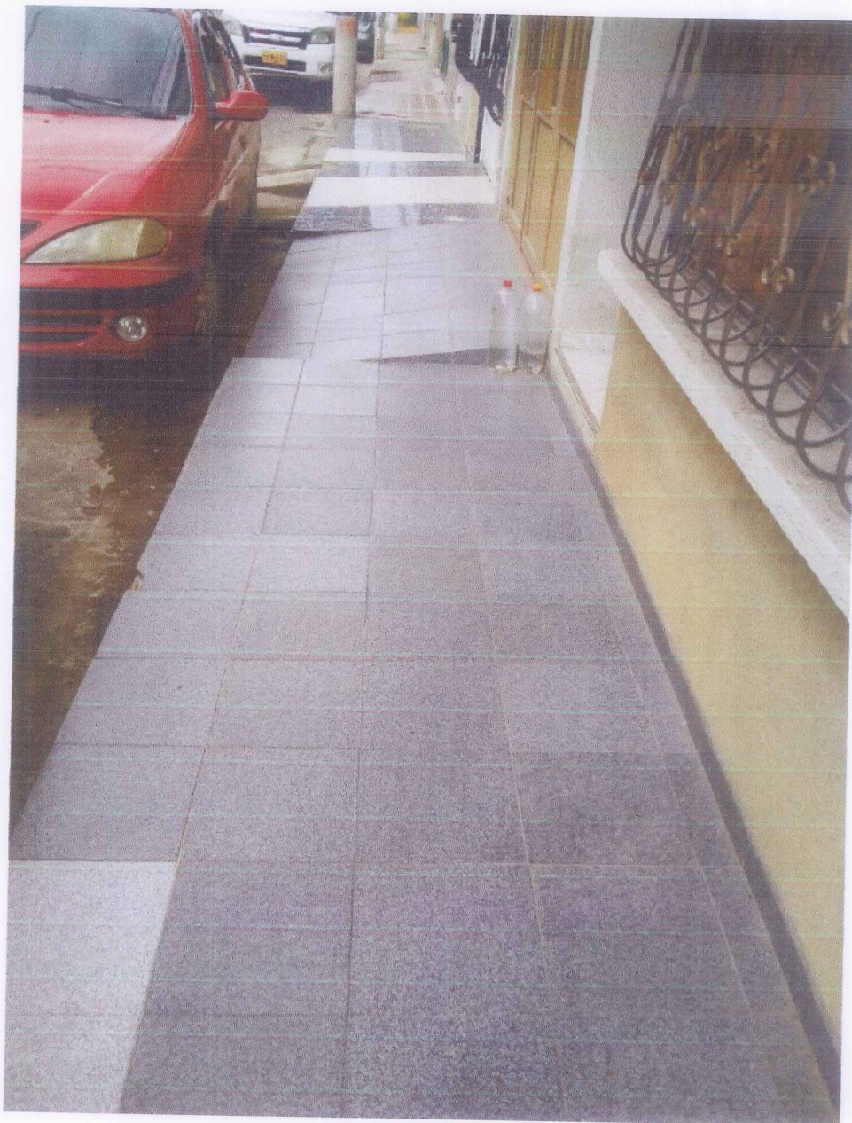
ESTADO ACTUAL DEL ANDÉN
