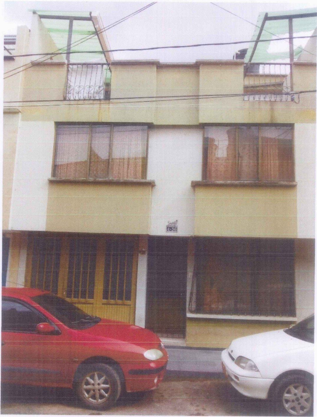
FACHADA DE LA VIVIENDA CARRERA 45 # 4-36
