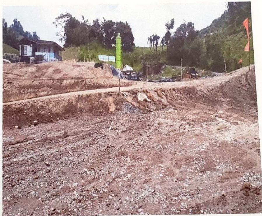
Parte del lote que nos están perturbando y nos quitaron del contrato de arrendamiento.
