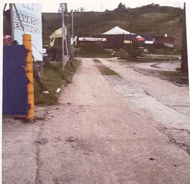
Vía acceso al lava autos donde se evidencia el material particulado dejado por el transporte realizado por las volquetas de constructora Hungría y TM S.A.
