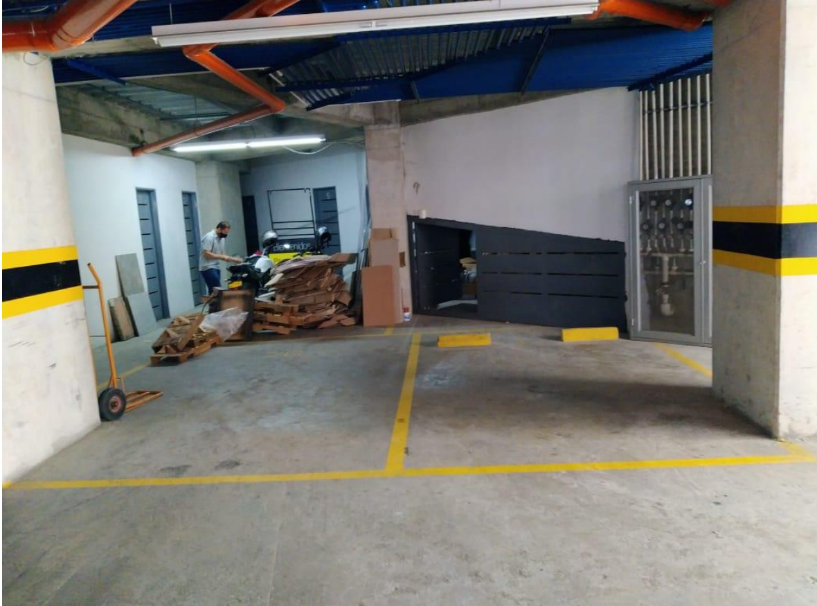
ACCESO AL PREDIO
