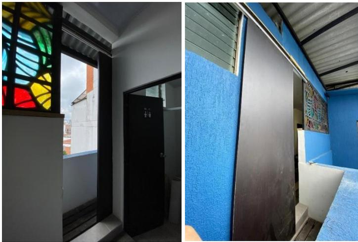
*Imagen 10. Puerta con los ajustes realizados en cuanto a cambio de chapa, y riel de trabajo pesado. – Imagen 11. Estado de la puerta, sin rayones ni afectaciones.*
