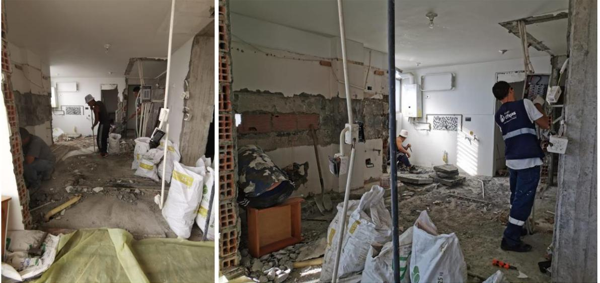
Imagen 6 y 7. Picado y preparado de piso para nivelación.
