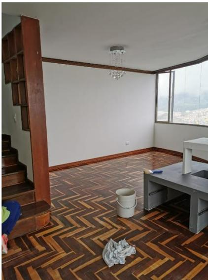
Imagen 16. Piso con destronque realizado, preparado para inicial proceso de pulido
