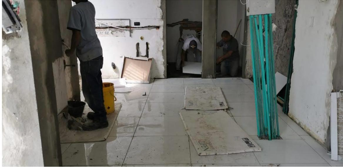
*Imagen 8. Enchape de cocina – se observa la continuidad del enchape.*
