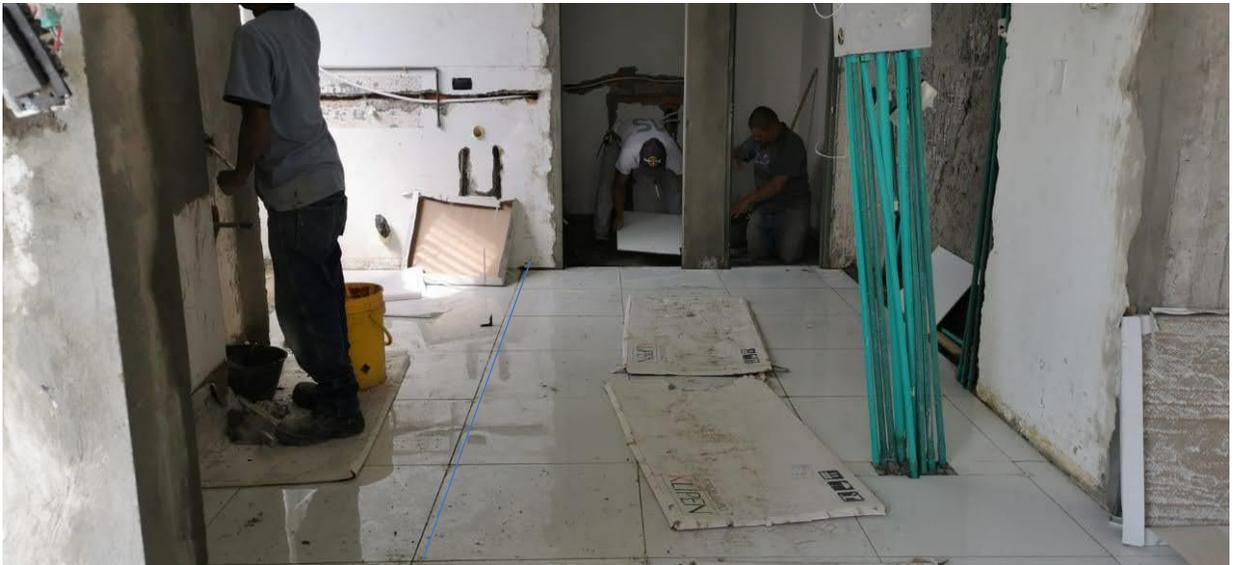
Imagen 8. Enchape de cocina – se observa la continuidad del enchape.
