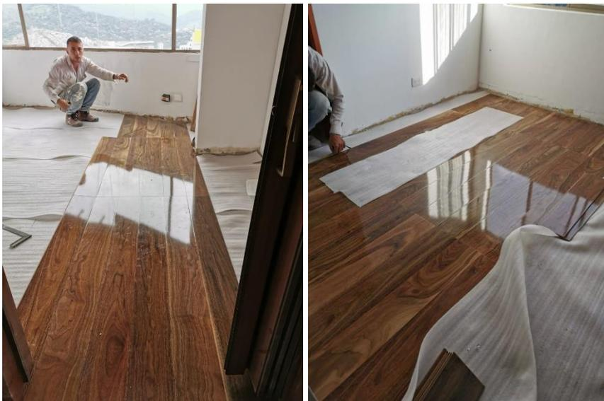
Imagen 2 y 3. Instalación piso laminado con la base de laminado (Yumbolon).
