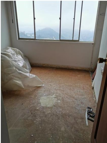
Imagen 1. Limpieza y nivelación de piso antes de instalación piso laminado
