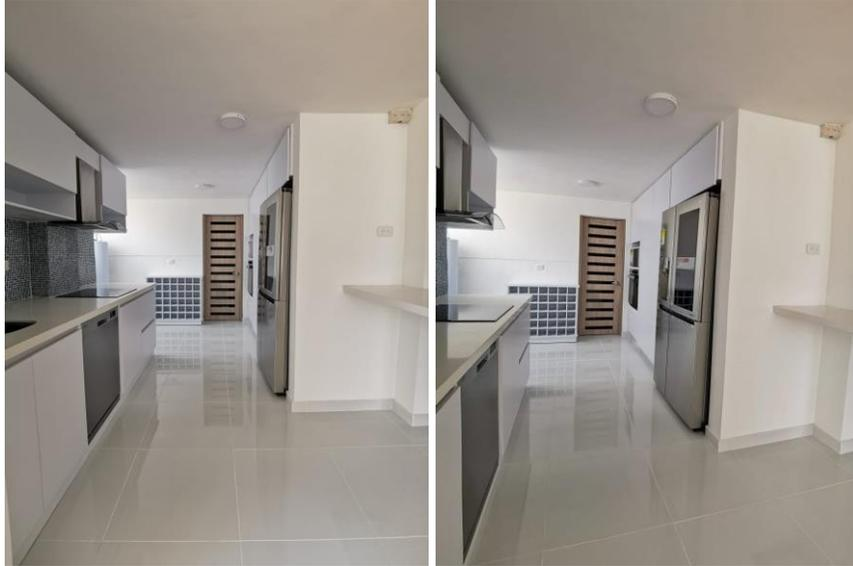
*Imagen 9 y 10. Enchape de cocina entregado, sin picaduras en sus piezas, se observa continuidad entre piezas, la fragua y su color son constantes.*
