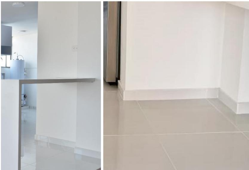
Imagen 15. Guardaescobas cocina a 90° con buen acabado, con remate superior limpio.
