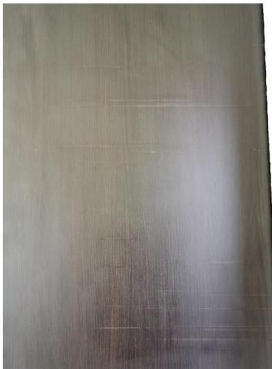
*Imagen 12. En visita de 27 de marzo de 2020, se observa que el elemento que fue ajustado y arreglado, presenta ralladuras en toda la superficie.*
