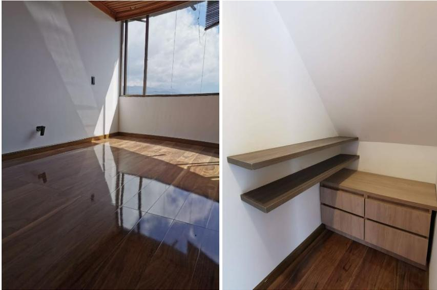
Imagen 4 y 5. Piso laminado instalado en habitación y closet intermedio y sin pandeos.
