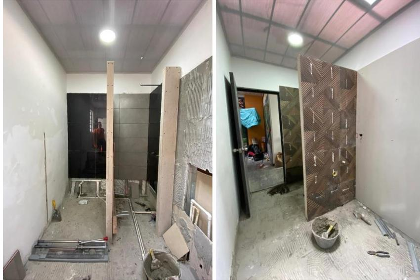
*Imagen 1 y 2. Piso baño caballeros y baño damas, preparado antes de realizar la actividad de instalación de enchape en piso.*
