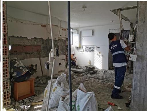
*Imagen 6 y 7. Picado y preparado de piso para nivelación.*
