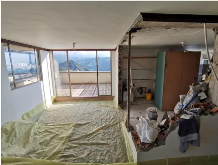
Imagen. Piso laminado cubierto con aislante para protección.
