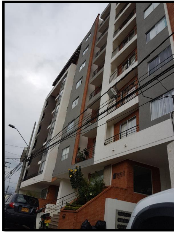
VISTA GENERAL EDIFICIO TRENTO 21
